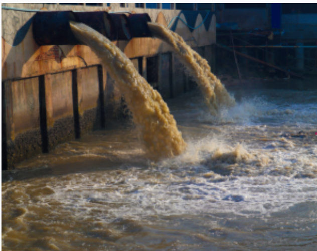
Wastewater Treatment Plant โรงงานบำบัดน้ำเสีย
