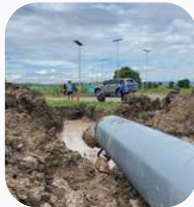
งานเดินลอดท่อส่งน้ำชลประทาน สระบุรี บริษัท สยามมิตร คอนเน็ค จำกัด
