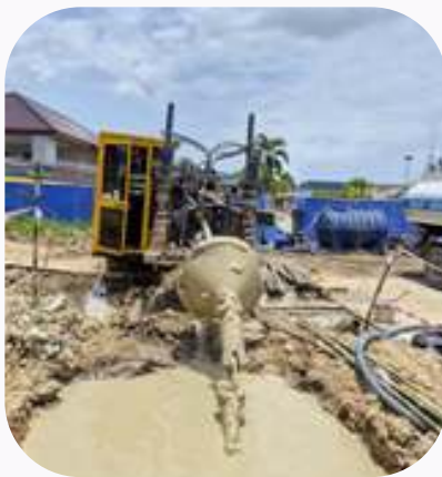
งานเดินลอดท่อสายไฟฟ้าลงใต้ดิน การไฟฟ้าเพชบุรี บริษัท พงศกร ก่อสร้าง จำกัด
