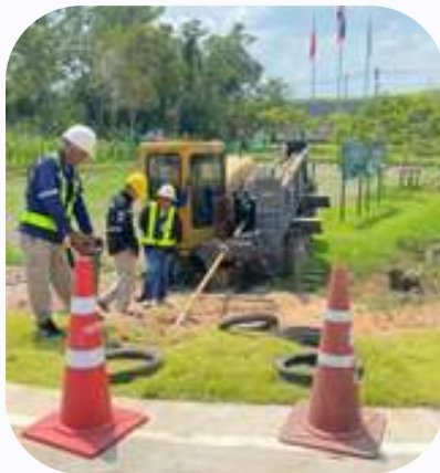
งานดินลอดท่อร้อยสายสื่อสาร CCTV บริษัท หาดทิพย์ จำกัด (สุราษฎร์ธานี)
