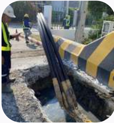
งานดินลอดท่อพร้อมติดตั้งบ่อพักสายไฟแรงสูง บริษัท ไอเรียนเต็ลคอปเปอร์ จำกัด
