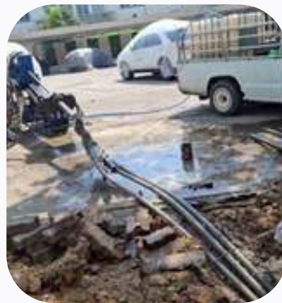
งานเดินลอดท่อร้อยสื่อสาร พร้อมติดตั้งบ่อพัก บริษัท นวัตกรรมเทคโนโลยีอินฟอร์เมชัน จำกัด
