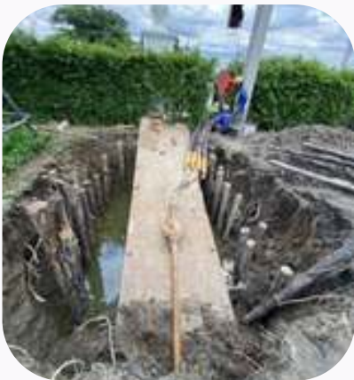
งานดินลอดท่อสายไฟฟ้าลงใต้ดิน ปทุมธานี บริษัท กรีนโมชั่นเทค จำกัด
