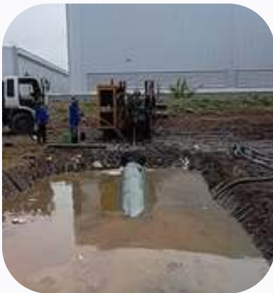
งานเดินลอดท่อส่งน้ำนิคมเอเชีย สุวรรณภูมิ บริษัท โกนจา จำกัด
