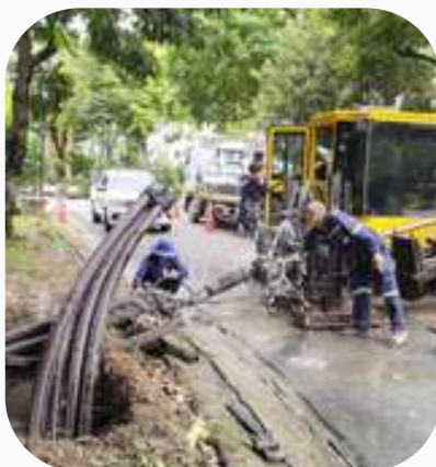
งานดินลอดท่อร้อยสายสื่อสาร พร้อมติดตั้งบ่อพัก ธนาคารแห่งประเทศไทย
